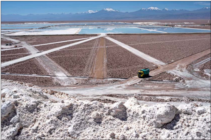
La extracción directa de litio, a diferencia de la técnica típica de extracción del metal, no evapora el agua de la salmuera. La iniciativa estará en el mismo salar de Atacama.
