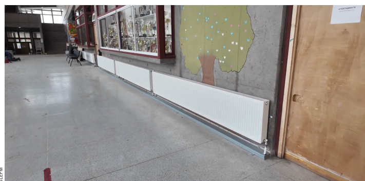
Las nueva calefacción ya están instalada en el patio común del liceo.
