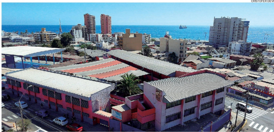
PLAGA DE ROEDORES Y PROBLEMAS EN CAÑERÍAS, ENTRE FALENCIAS PRESENTADAS EN ALGUNOS ESTABLECIMIENTOS DE ANTOFAGASTA.
