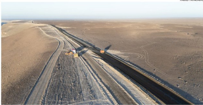
LAS OBRAS DE VIALIDAD SE EJECUTAN EN UNA ZONA CON VESTIGIOS ARQUEOLÓGICOS.
