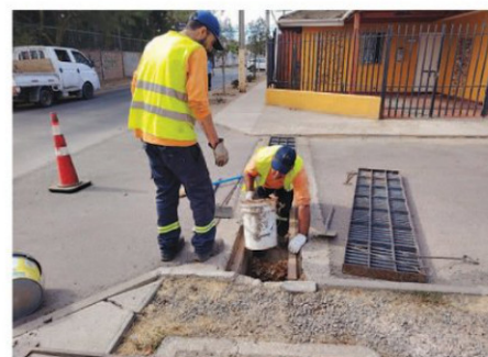
EN LAS POBLACIONES SE DESTAPAN CANALETAS SUBTERRÁNEAS.
