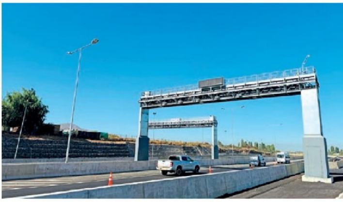
Los vehículos que cuenten con TAG habilitado de cualquier autopista podrán circular sin detenerse y sin necesidad de portar efectivo, lo que permitirá viajes más ágiles, fluidos y seguros.
