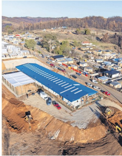
La nueva escuela contempla 800 metros cuadrados de construcción distribuidos en 55 módulos de alto estándar.
