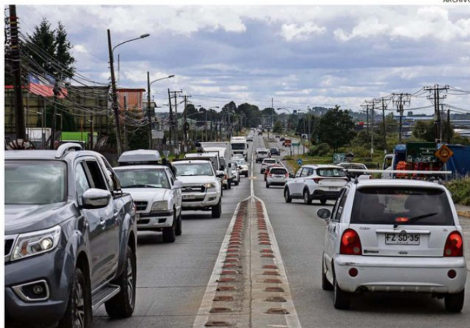
WAINRAIGHT ESPERA AGILIZAR LAS EXPROPIACIONES EN LA RUTA EL TEPUAL, PARA INICIAR OBRAS EN 2027.
