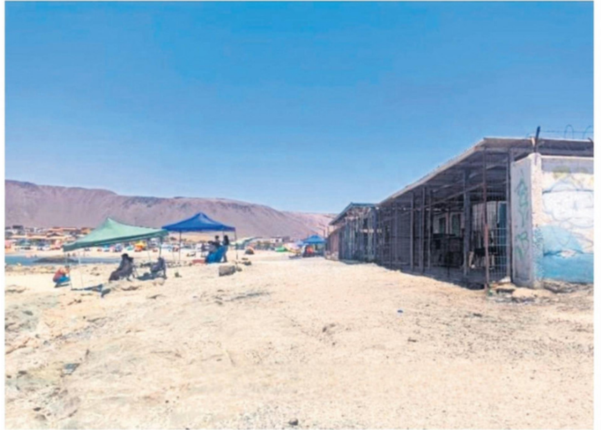
COMUNIDAD DENUNCIA QUE ESTAS CABAÑAS NO ESTÁN CONECTADAS AL ALCANTARILLADO.
