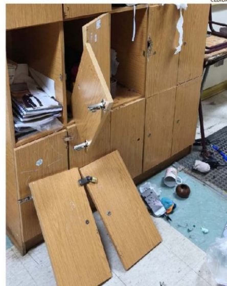
EL MOBILIARIO ESTABA CON EVIDENTE DAÑOS EN LAS OFICINAS.
