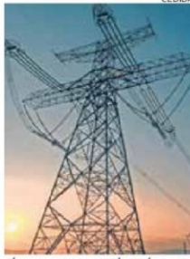
LÍNEA DE TRANSMISIÓN ELÉCTRICA.
