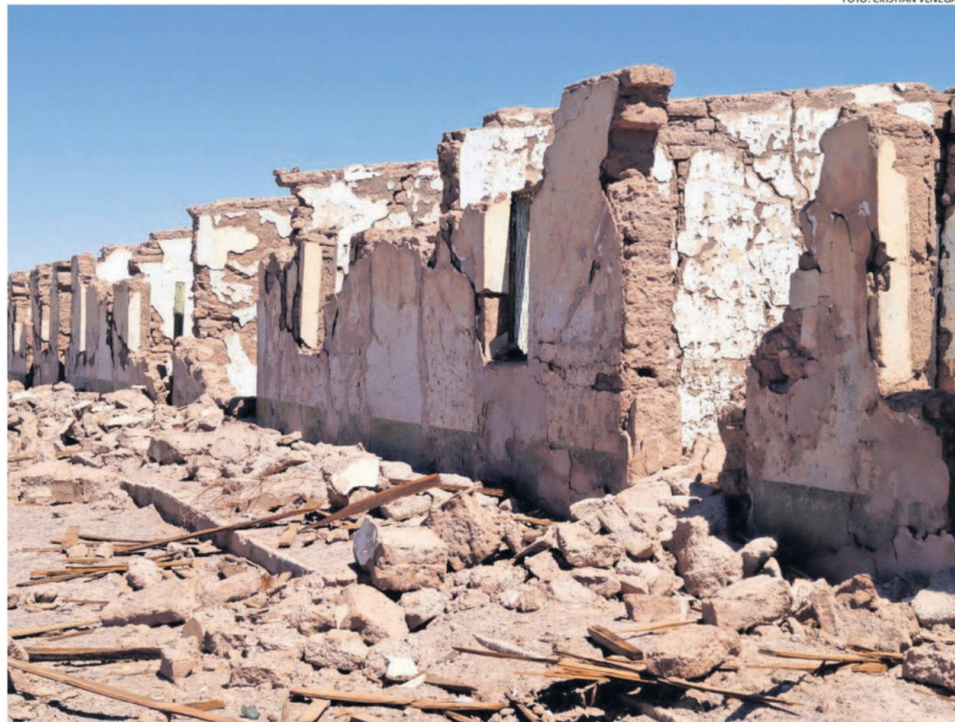
LAS RUIÑOSAS PAREDES DE CONCRETO DE LAS VIEJAS VIVIENDAS ES TODO LO QUE QUEDA DE LA EXOFICINA JOSÉ FRANCISCO VERGARA.
