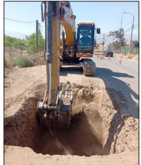
Obras tuvieron inversión superior a los $1.300 millones.
