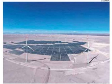
EL COMPLEJO REÚNE ENERGÍA SOLAR, EÓLICA Y ALMACENAMIENTO.
