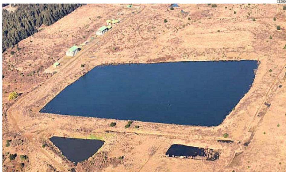
EN LA PISCINA GRANDE SE ACUMULARON 200 MIL METROS CÚBICOS DE AGUA, LOS QUE ESTÁN SIENDO EXTRAÍDOS DESDE HACE UN MES.
