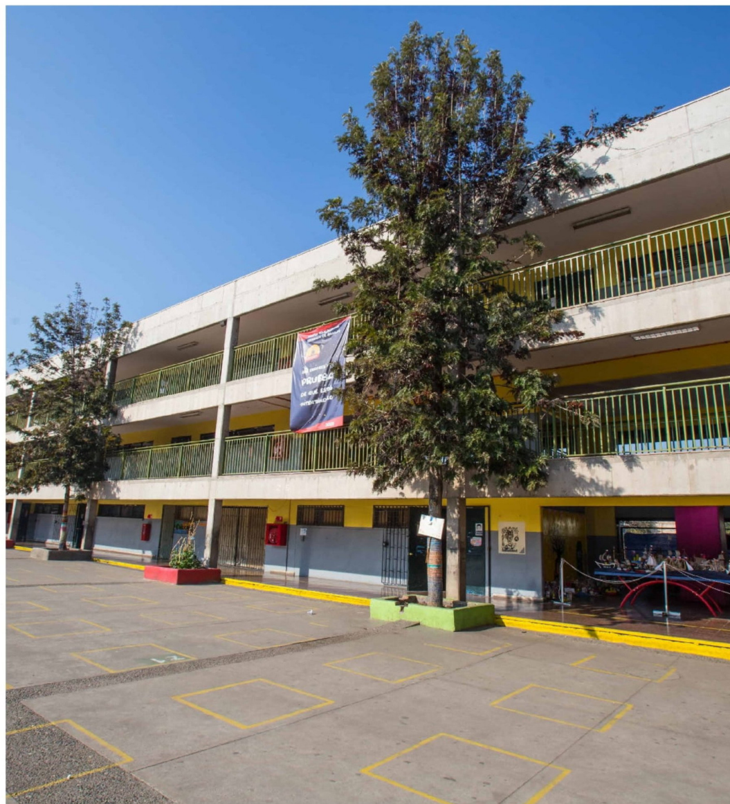
► A pesar de estar aprobada, la norma no permite instalar detectores de manera inmediata ni sin condiciones.
