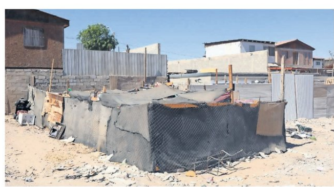
ALGUNOS RUCOS CONTABAN CON MATERIAL LIGERO PARA SU CONSTRUCCIÓN, ESTE FUE DEMOLIDO CON MÁQUINA.
