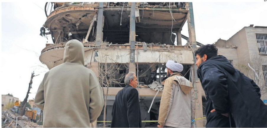
EDIFICIO EN TEHERÁN DONDE FUNCIONABAN MEDIOS DE COMUNICACIÓN ALCANZADO POR BOMBARDEO.
