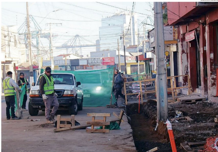
LA INICIATIVA CONSIDERABA UN PLAZO DE EJECUCIÓN DE 360 DÍAS POR PARTE DE LA EMPRESA A CARGO DE LAS OBRAS.
