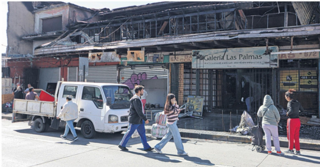
INCENDIO DESTRUYÓ LOCALES DE LA GALERÍA LAS PALMAS EN EL MERCADO CENTRAL DURANTE LA SEMANA PASADA.
