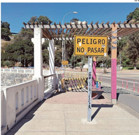
LOS TRABAJOS DEBIERAN CONTINUAR POR AV. ALTAMIRANO.
