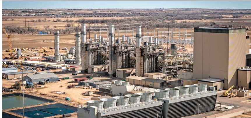
Una central eléctrica de gas en Colorado.
