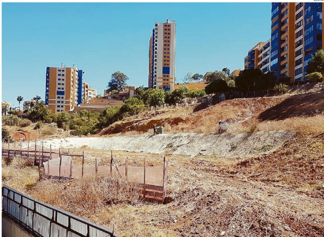
EN LO ALTO DEL CERRO, EL TERRENO ESTÁ SIENDO APLANADO PARA ALZAR CINCO TORRES DE 15 NIVELES PARA MÁS DE 2 MIL PERSONAS.
