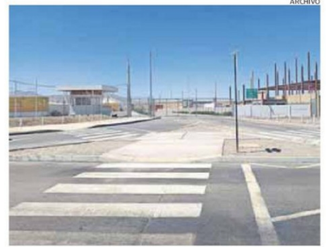
OPERACIONES EN EL NUEVO RODOVIARIO YA COMENZARON.
