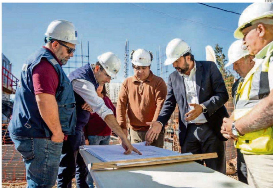
INCLUIRÁ DORMITORIOS, ENFERMERÍA, COCINA, LAVANDERÍA, PATIOS CUBIERTOS, ÁREAS VERDES, ESPACIOS COMUNES Y EQUIPAMIENTO ESPECIALIZADO.
