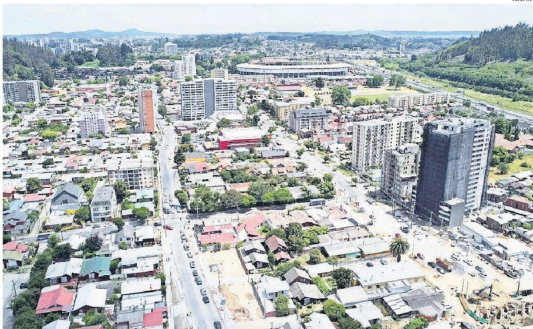
EL PROYECTO BUSCA RENOVAR LAS AVENIDAS COLLAO Y NOVOA, CONECTANDO CON EL TRAMO QUE YA SE MEJORÓ CERCA DE LA UBB.
