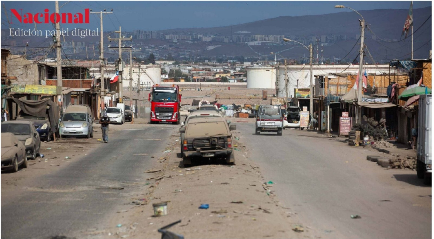
► Zona del cerro Chuño en Arica, donde se hará solo demolición sin reconstrucción, al ser un lugar con materiales tóxicos.
