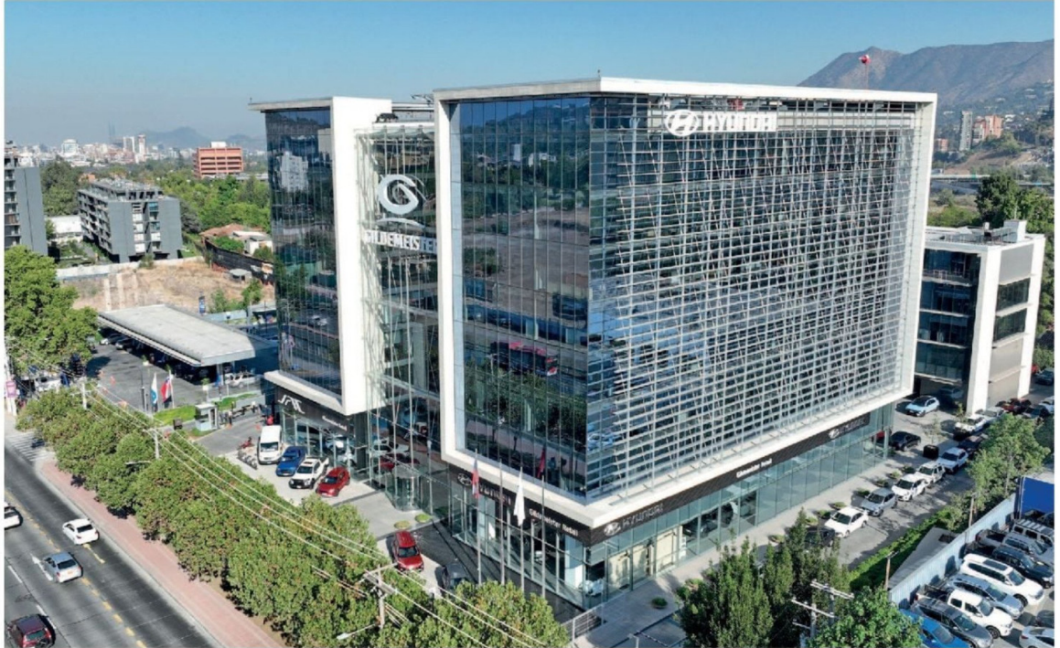
Edificio corporativo de Gildemeister en Las Condes, con oficinas y showroom exclusivo de Hyundai.
