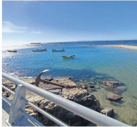
La obra fue comprometida en 2023 tras incendio.
