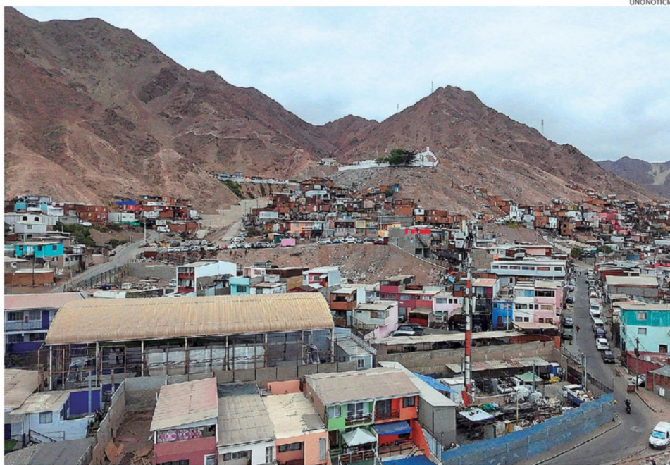
LOS ASENTAMIENTOS ILEGALES SE EXTIENDEN A LO LARGO DE TODA LA EXTENSIÓN DE LA VÍA ALUVIONAL.
