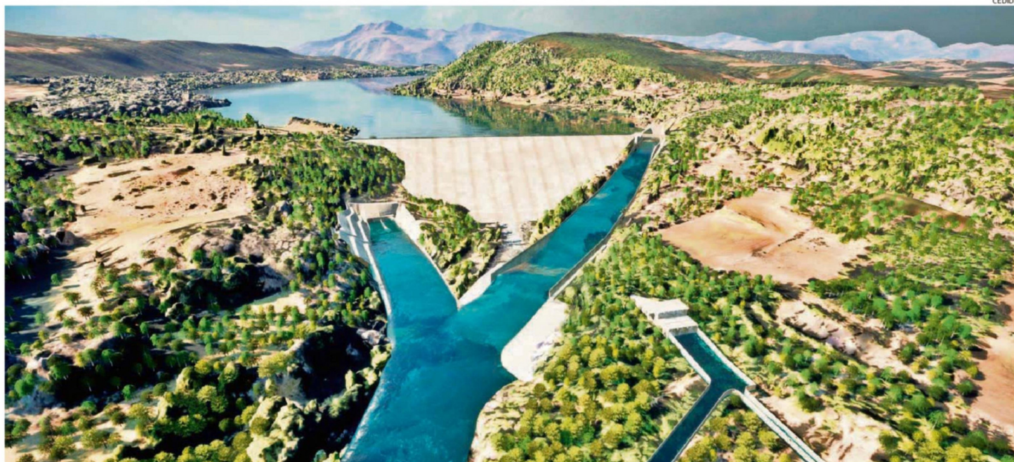
EL EMBALSE ZAPALLAR INICIÓ SU CONSTRUCCIÓN EN ENERO DE ESTE AÑO. SE ESPERA POR LA CONCRECIÓN Y DEFINICIONES SOBRE EL CHILLÁN Y LA PUNILLA.
