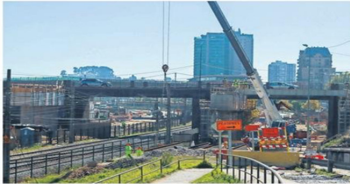
El paso sobrenivel debería estar listo el primer semestre del 2027.
