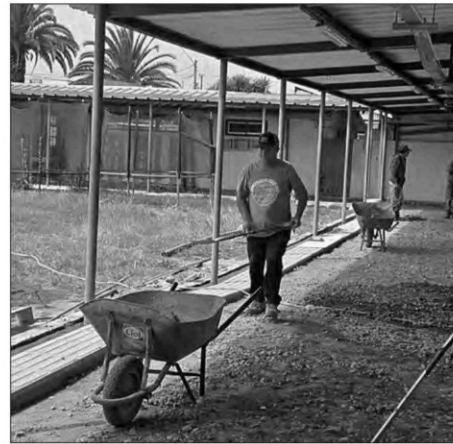
Tras conversaciones con la empresa constructora y el Ministerio de Educación, se acordó adelantar parte de los trabajos para reducir el impacto en la comunidad educativa.
