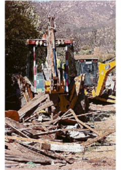
TRABAJARON EQUIPOS MUNICIPALES.
