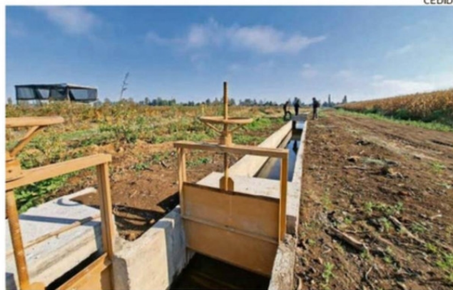
OBRAS ESTÁN ACTUALMENTE EN EJECUCIÓN.
