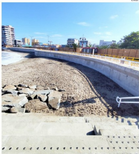
LA OBRA PERMITIÓ RECUPERAR UN ESPACIO DE LA PLAYA.
