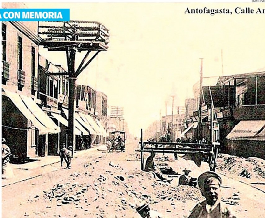
TRABAJOS DE ALCANTARILLADO EN CALLE ANGAMOS (MATTA) ESQUINA PRAT EN 1913.
