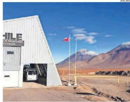
HITO CAJÓN SE UBICA EN LA RUTA 27CH EN LA COMUNA DE SAN PEDRO.
