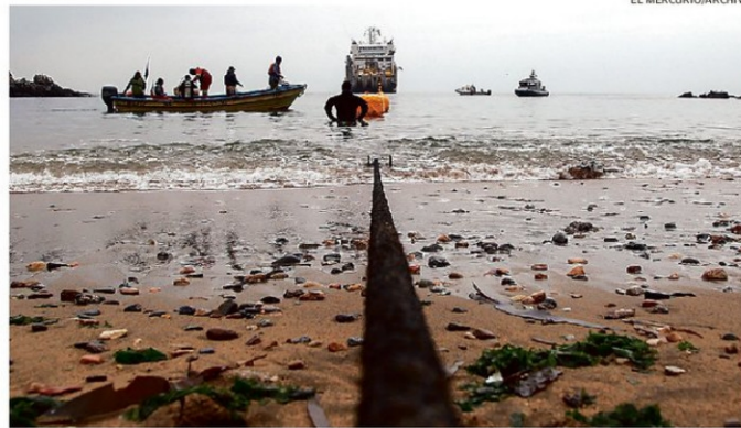
ANCLAJE TERRESTRE EN PLAYA ANCHA DE LA FIBRA ÓPTICA SUBMARINA “CURIE”, DE GOOGLE, REALIZADO EN 2019.
