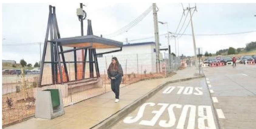
Uno de los paraderos de locomoción habilitados en villa Los Sauces: sólo falta que circulen los taxis colectivos y las micros.
