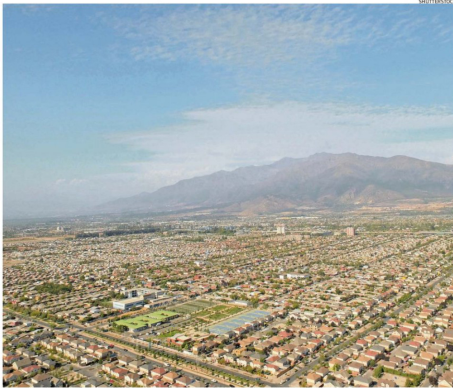
La comuna de Puente Alto es una de las comunas que está sobre el “clúster sísmico”.
