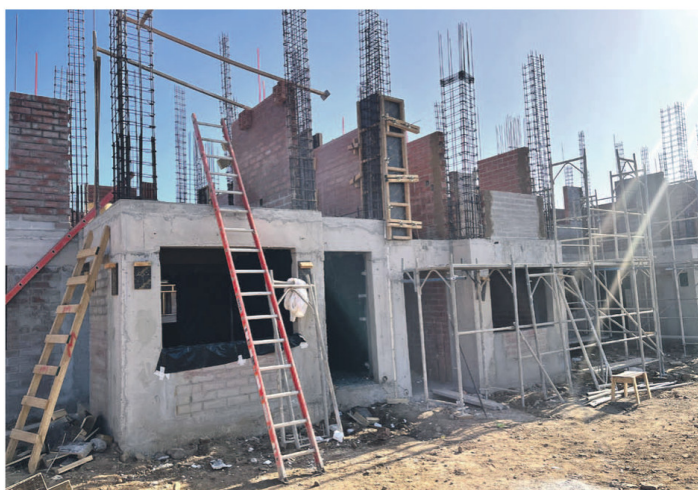
Al momento de la detención de las obras el avance financiero de la obra alcanzaba un 31,27%, mientras que el avance físico apenas llegaba al 24,2%.
