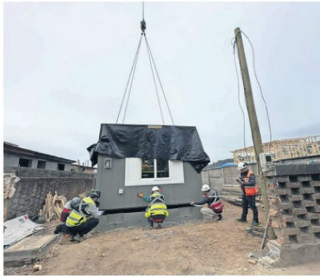
Una de las viviendas siendo instalada a través de módulos.
