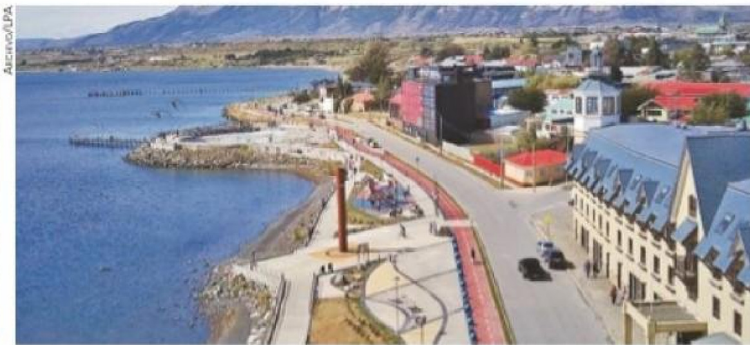
El nuevo sistema de locomoción colectiva mayor necesita habilitar más de 80 paradas, las que incluyen la instalación de 14 nuevos paraderos cubiertos.
