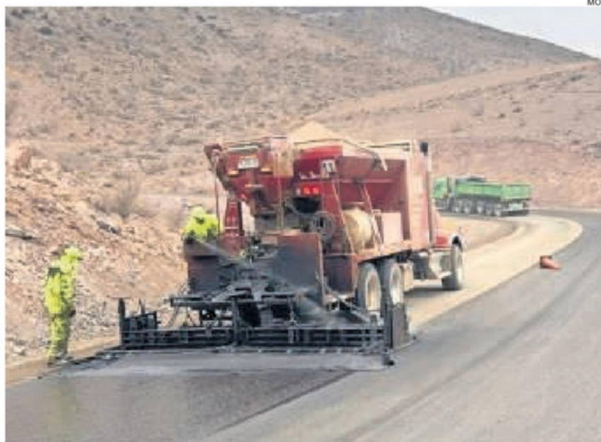
LA DIRECCIÓN REGIONAL DE VIALIDAD FINALIZÓ CON LA PAVIMENTACIÓN.
