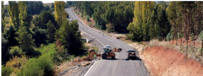
LA PAVIMENTACIÓN HISTÓRICA de la ruta Yumbel-Rere estará lista prontamente.
