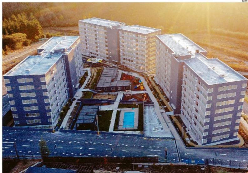
CONJUNTO HABITACIONAL “VISTAS DE CURAUMA I” SE ENCUENTRA AL NORPONIENTE DE PLACILLA.
