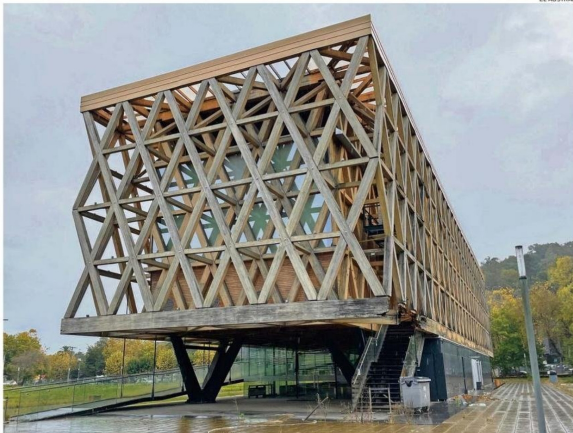
EL PABELLÓN SE INSTALÓ A LOS PIES DEL CERRO ÑIELOL A FINES DE 2016 Y DESDE ENTONCES HA ESTADO EXPUESTO A UN CLIMA HÚMEDO Y LLUVIOSO.
