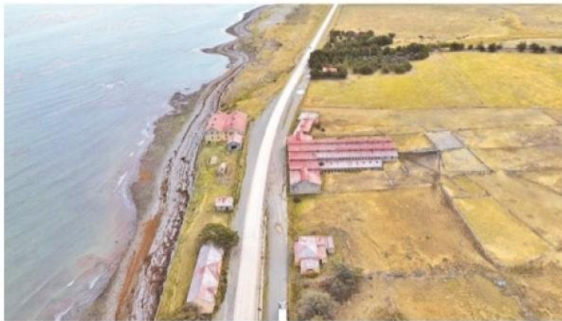
Uno de los puntos más sensibles se relaciona con la Zona Típica Estancia San Gregorio, sitio de valor patrimonial declarado por el Consejo de Monumentos Nacionales que queda directamente en la ruta de las obras.
