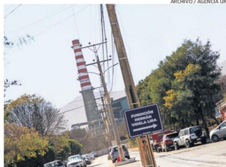
EL OBJETIVO ES INVERTIR UNOS US$65 MILLONES EN ADECUACIONES, QUE INCLUYE DEMOLER OBRAS QUE ANTES SE PENSARON EN REUTILIZAR.
